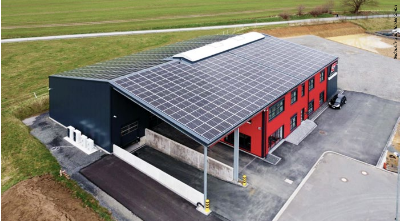
Firmensitz der Sauerländer GmbH mit PV-Anlage und Wärmepumpen-Außeneinheiten von Hisense
