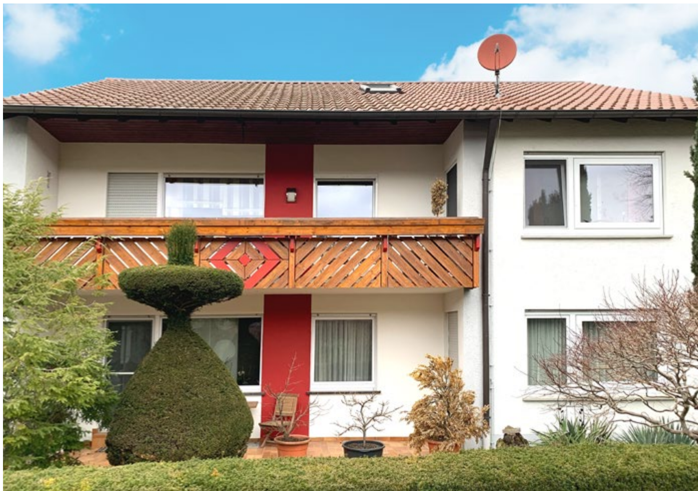
In einer Bestandsimmobilie wurde die Ölheizung durch Hitachi Hochtemperatur-Wärmepumpen ersetzt
