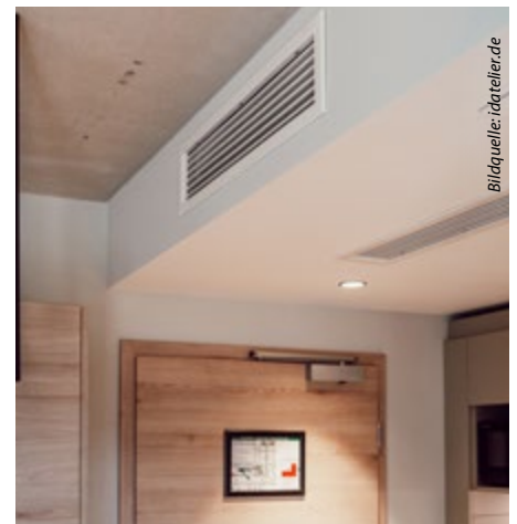
Nahezu unsichtbare Installation von Kanalanschlussgeräten
