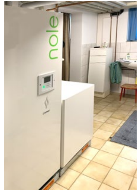
Hydraulikmodul + Brauchwasserspeicher
