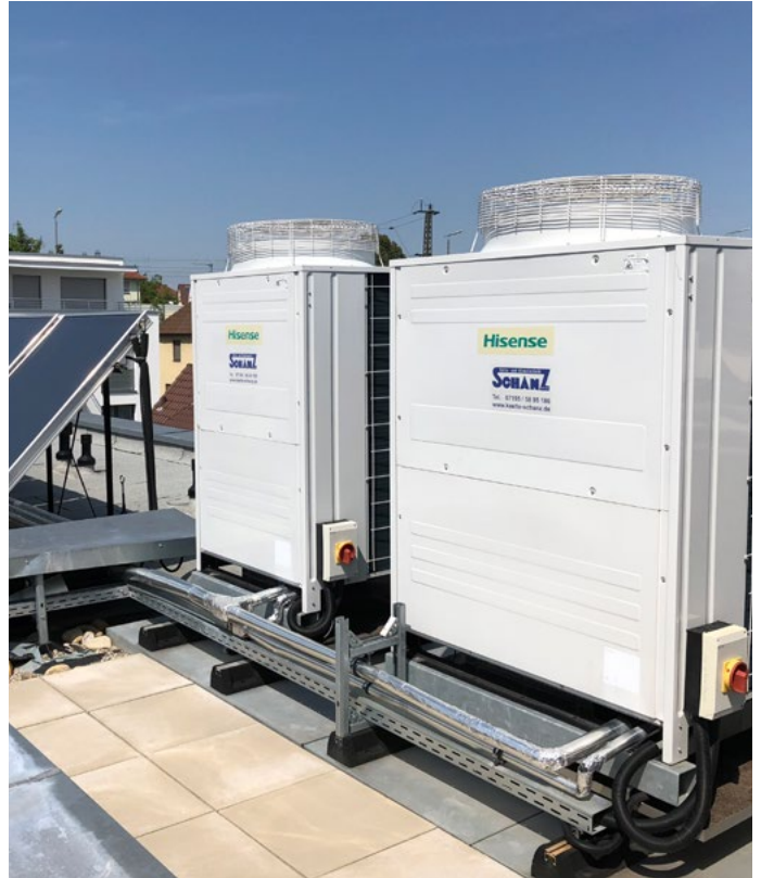
Dachinstallation der Außeneinheiten
