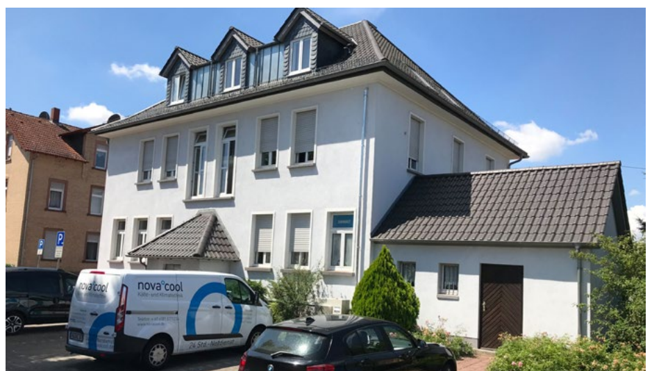
Denkmalgeschütztes Gebäude mit Kältemittelleitung in vertikalem Fallrohr
